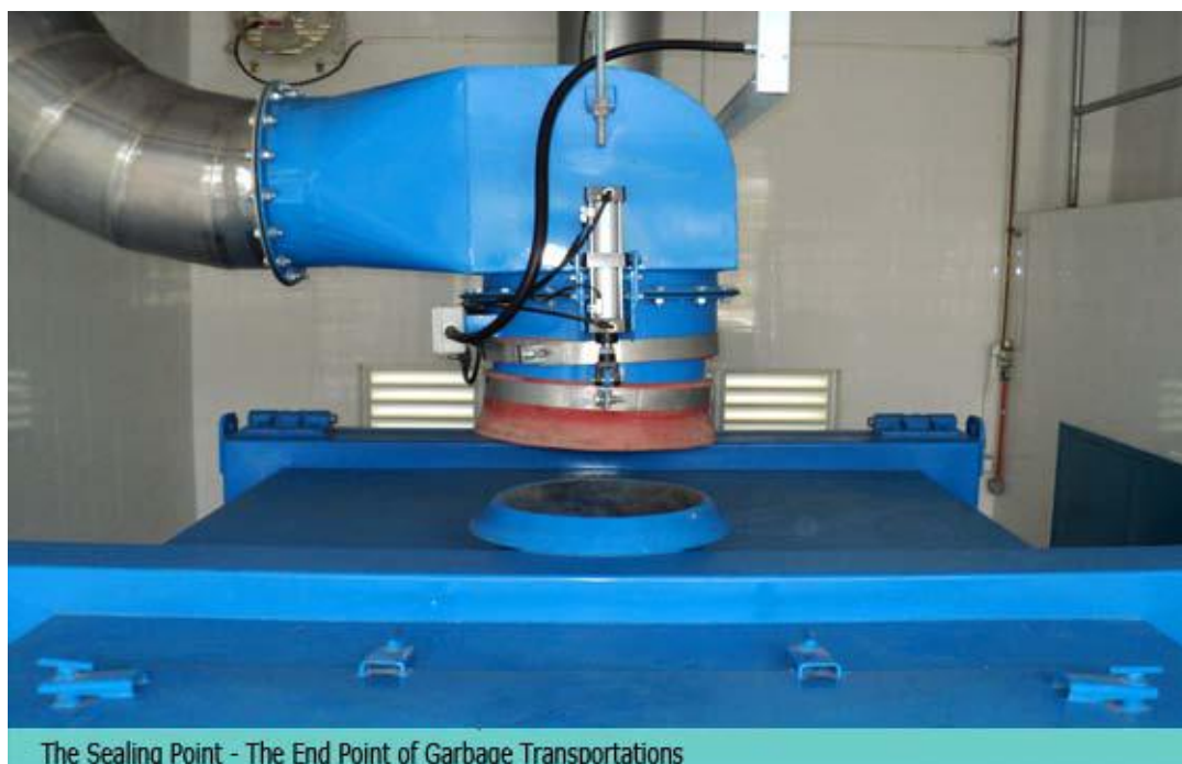
Εικόνα 40: Εφαρμογή Σωλήνα στον Απορροφητήρα
