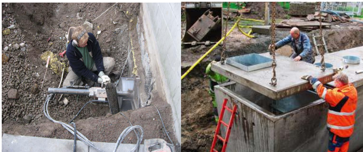
Εικόνα 44: Εργασίες Τοποθέτησης Περιφερειακών Δοχείων
