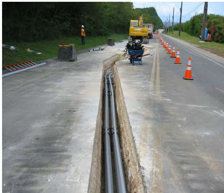
Εικόνα 32: Απεικόνιση Διάνοιξης με ανοιχτή εσκαφή
