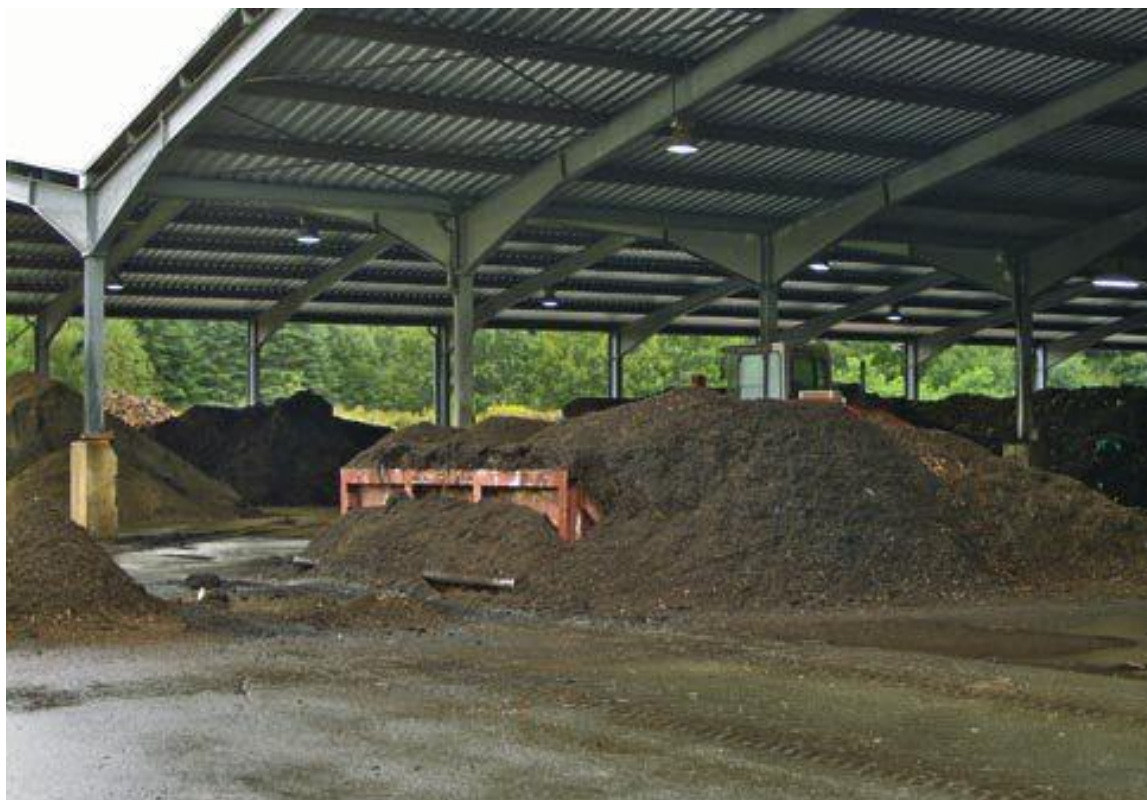
Εικόνα 55: Χώρος Αποθήκευσης & Επεξεργασίας Κομπόστ
